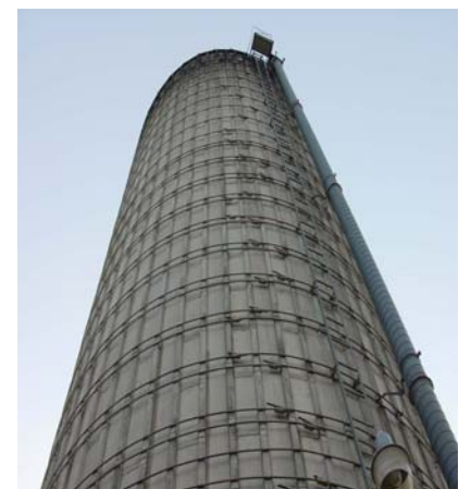
Figura 3.3.d. El gas del lugar de almacenamiento de granos, puede dejar a una persona inconsciente o muerta. Es muy difícil rescatar a una víctima dentro de un almacenamiento de granos en la finca.
