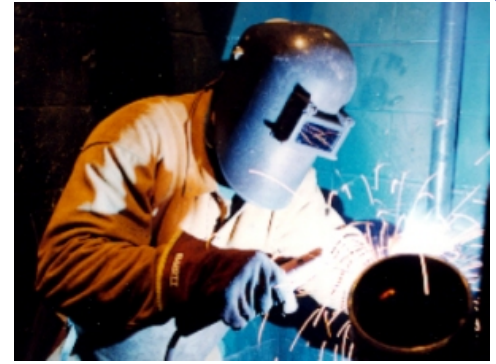
Figura 3.3.c. La soldadura produce humos. Cuando los metales se derriten y la varilla de soldar y la chispa se queman, se producen humos. Estos humos pueden causar irritación en la nariz y los pulmones.
